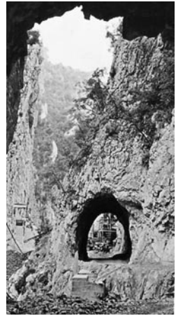
Izgradnja pruge na dionici Lutovo – Krušev potok...
